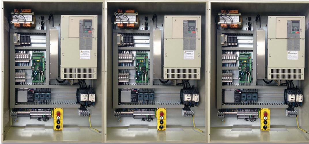
Quadro HI-TEC triplex - 18 fermate - 2,00 m/s - tecnologia seriale di piano e cabina.
